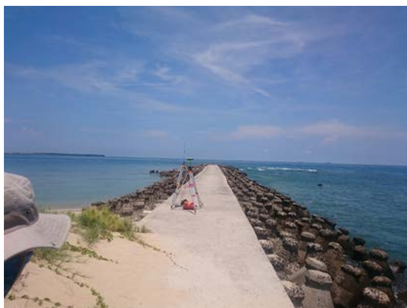
圖十、RTK-GPS 基準站架設(隘門沙灘)
