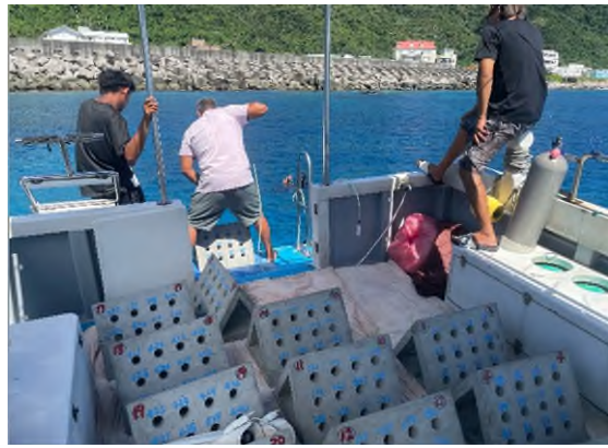
照片 12. 珊瑚移植磚人力吊放入海(移植點)
