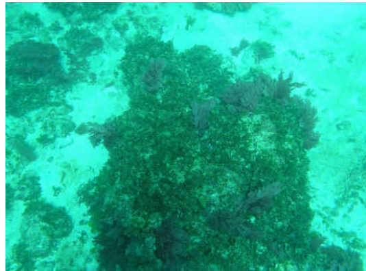
圖 37、2 號艙蓋破壞區的藻類繁盛。(20050516 近岸區)
