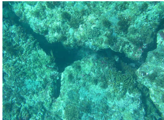
圖 15、鄰近 5 號艙蓋的珊瑚礁體裂縫與鄰近生物群聚。(20050523 近岸區)
