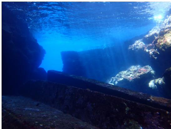
近岸水下有掉落的道路結構物
